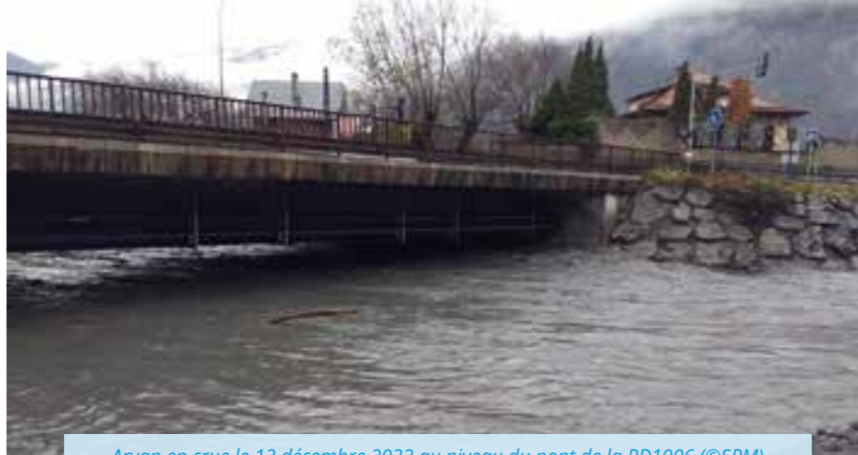
Arvan en crue le 12 décembre 2023 au niveau du pont de la RD1006 (©SPM)
